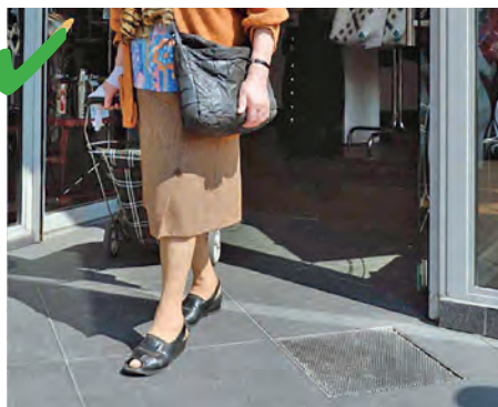
😊 Exemple d'une entrée de magasin de plain-pied.
